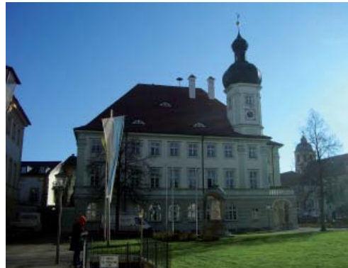
Abbildung 64 (rechts): Bereich Kapellplatz Quelle: D I S
