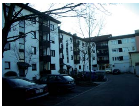
Abbildung 96: An der Alten Post 9, 11 und 13 Quelle: D I S
