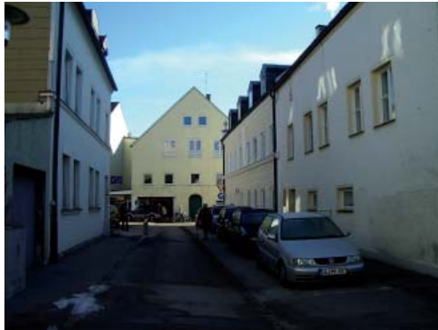
Abbildung 99: Josefsburggasse - Blick Richtung Trostberger Straße Quelle: D I S
