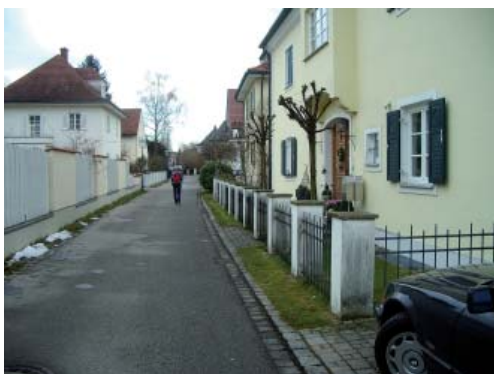
Abbildung 116: 2- bis 3-geschossige Gebäude entlang der Neuen Gasse Quelle: D I S
