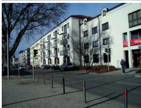
Abbildung 77: Bahnhofplatz 8 und 10 Quelle: D I S
