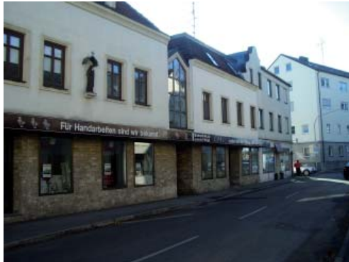
Abbildung 79: Trostberger Straße 9, 13 und 15 Quelle: D I S
