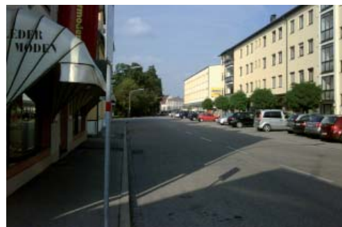
Abbildung 195 und 196: Trostberger Straße; beide Bilder zeigen die viel zu schmalen Gehwege, die zudem wenig attraktiv gestaltet sind. Die Autos stehen teilweise ungeordnet am Straßenrand. Quelle: D I S
