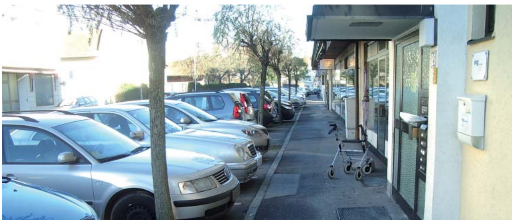
Abbildung 197: Trostberger Straße schmalen Gehweg, der wenig Verweilqualität und Flickstellen aufweist Quelle: D I S
