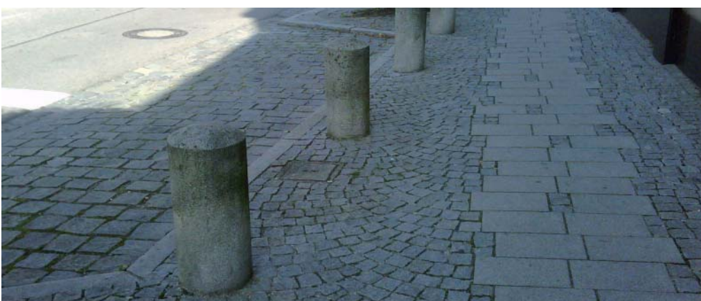
Abbildung 189: Die Neuöttinger Straße südlich des Inneren Ringes. Der Gehwegbereich und der Parkstreifen für Pkw sind gepflastert. Poller grenzen die beiden Teilflächen voneinander ab. Quelle: D I S
