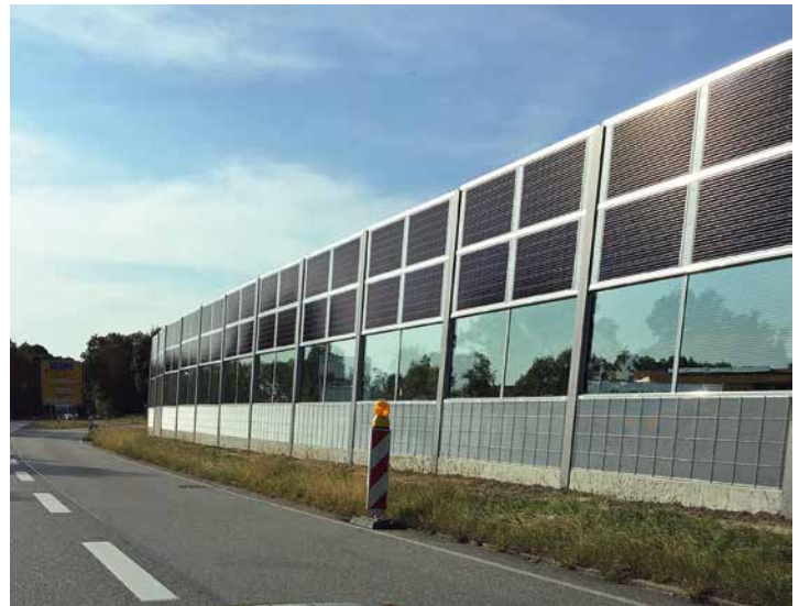
In der Fachwelt spricht man von einem Leuchtturmprojekt: Schallschutz und Energieerzeugung im Verbund. Foto: Dingl
