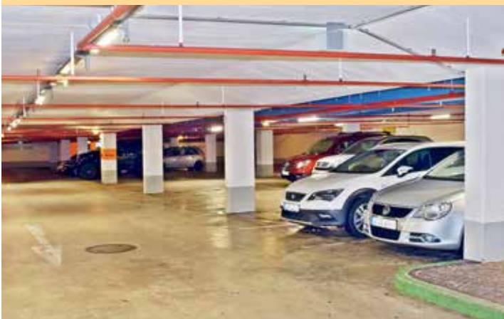
Das 2. Untergeschoss der Tiefgarage an der Hofmark. Foto: Stadt Altötting
