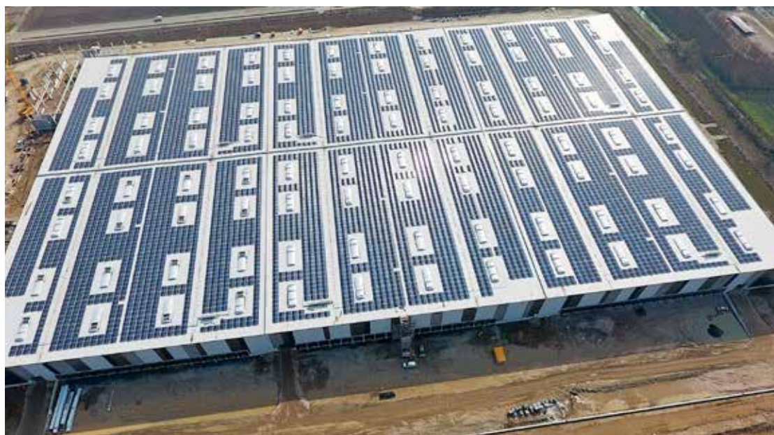
15.000 Module auf 50.000 Quadratmetern Dachfläche eines neuen Logistikzentrums in Frankenthal erzeugen jährlich mindestens 3,6 Mio Kilowattstunden Strom. Investor ist die Energiegenossenschaft Inn-Salzach eG.
