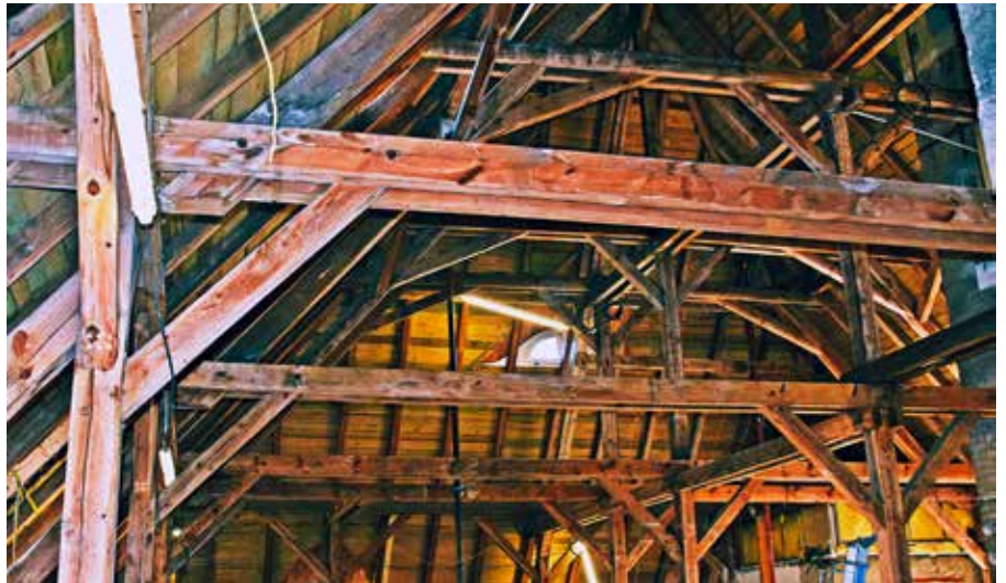
Der freigelegte Dachstuhl des Altöttinger Rathauses. Foto: Stadt Altötting
