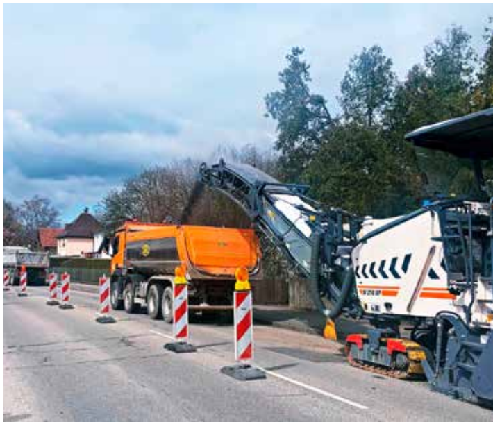
Unser Bild zeigt das Abfräsen der Asphaltsschicht
