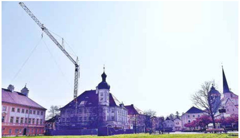
Ein riesiger Kran ist nötig, um die Umbaumaßnahmen im Dachstuhl möglich zu machen.
