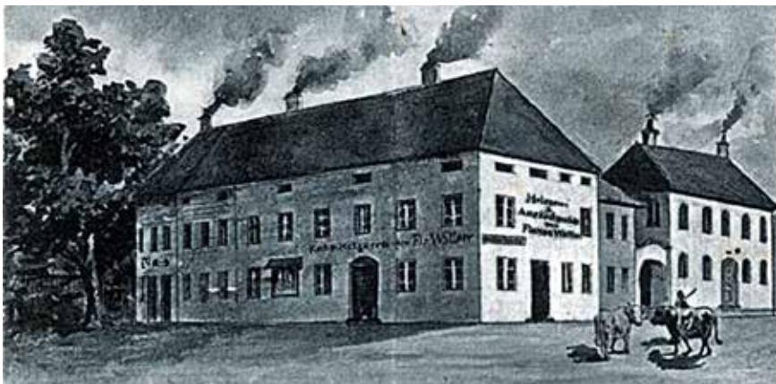
Metzgerei und Auskochgeschäft von Florian Wallner auf einer Postkarte von 1903. Das erste Haus an der Schlotthamer Straße (im Bild rechts) gehörte zu dieser Zeit ebenfalls zum Gebäudekomplex der Metzgerei. Links ist ein Teil von „Hubers Sommergarten“ zu sehen. Zwei ahnungslose Kühe vom benachbarten Schwanthalerhof werden gerade in den Schlachthof geführt. Die Lieferketten waren damals noch kurz: Das Vieh wurde über die Straße zum Metzger gebracht und das erzeugte Fleisch zum Verzehr dann in die gegenüberliegende Gastwirtschaft geliefert.
