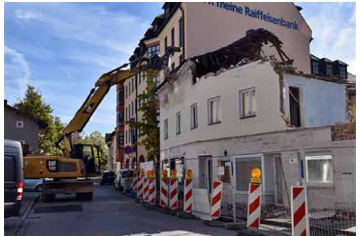
Die Abbrucharbeiten im Oktober 2021 schritten zügig voran. Es dauerte keine, drei Wochen, bis die lange Geschichte der Metzgerei Wallner besiegelt war.
