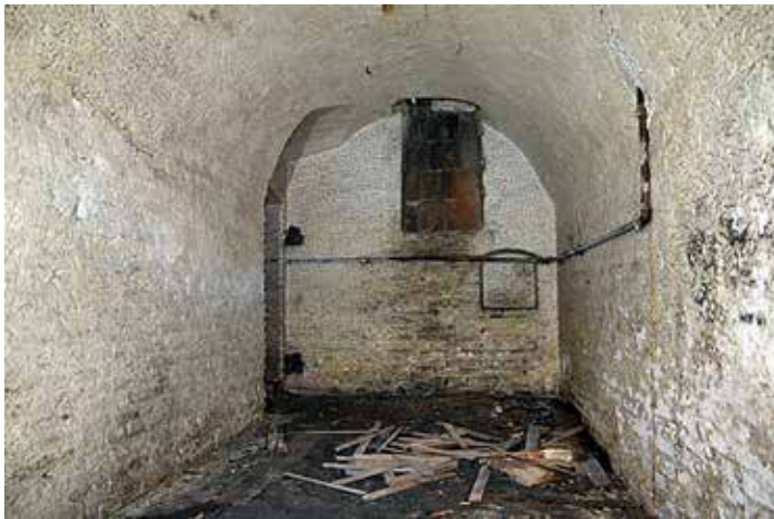
Dieser Keller mit Tonnengewölbe stammte wohl noch aus der Erbauungszeit des Anwesens vor mehreren hundert Jahren. Bevor es Kühlschränke gab waren diese Baulichkeiten als Vorratskeller besonders wichtig. Das kühle und feuchte Klima der Ziegelgewölbe war ideal zur Einlagerung von Obst und Gemüse.
