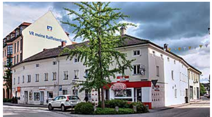
Die äußere Gestalt des Gebäudes der Metzgerei änderte sich über die Jahre kaum, wie man auf dieser Aufnahme aus dem Jahr 2016 erkennen kann. An der Straßenkreuzung war seit jeher das Metzgereigeschäft untergebracht. Dieser Teil repräsentierte auch den historischen Kern des Gesamtkomplexes.
