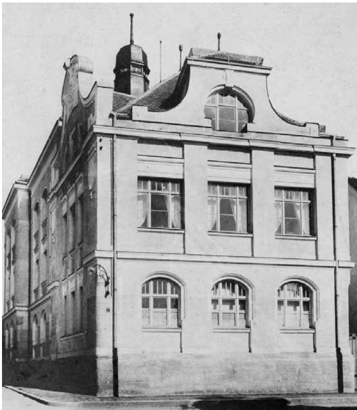
Der vordere Teil der Mädchenschule war nur zweistöckig ausgeführt und besonders aufwendig gestaltet. Die Fassade fügte sich gut in die Silhouette der umliegenden niedrigeren Häuser ein. Aufnahme von 1908.
