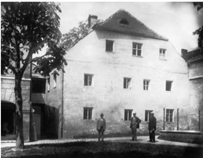
Das alte Stiftsschulhaus am Tillyplatz. Diese Aufnahme zeigt das Haus kurz vor dem Abbruch im Jahre 1922. Das Aussehen des Gebäudes hatte sich über die Jahrhunderte verändert, das ursprüngliche gotische Satteldach war einem Krüppeldach gewichen. Der Platz auf denen die Männer stehen, war bis 1803 der Friedhof in Altötting.
