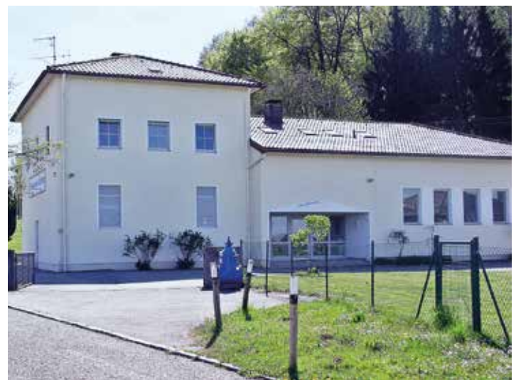
Das gemeinschaftliche Wasserwerk von Altötting, Neuötting und Winhöring an der Osterwies.
