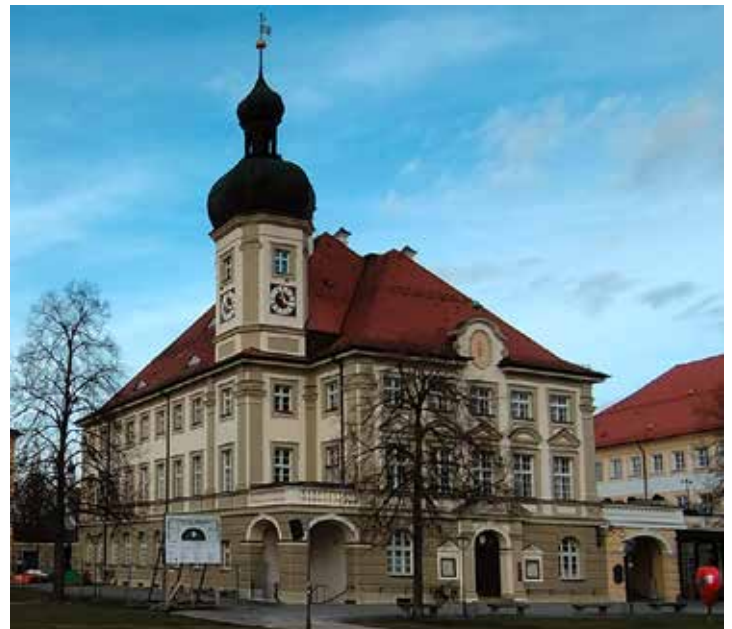
Anfang 2022, nachdem das Gerüst entfernt wurde, war das neu sanierte Rathaus nur für kurze Zeit in seiner Gesamtheit zu besichtigen. Schon bald wurde wieder ein Bauzaun aufgestellt, denn die Umbauarbeiten wurden fortgesetzt.
