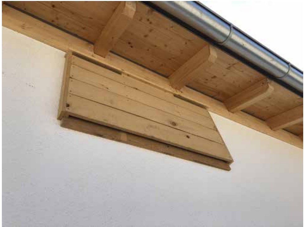
Doppelwandige Bretter, wie hier bei der Kläranlage in Altötting, nutzen Fledermäuse als Tagesquartier.
