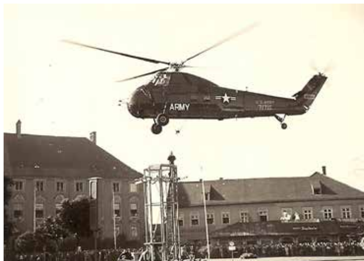
Ein Hubschrauber der US Army nimmt den neuen Kapellenturm auf, um ihn dann auf die Kapelle aufzusetzen.
