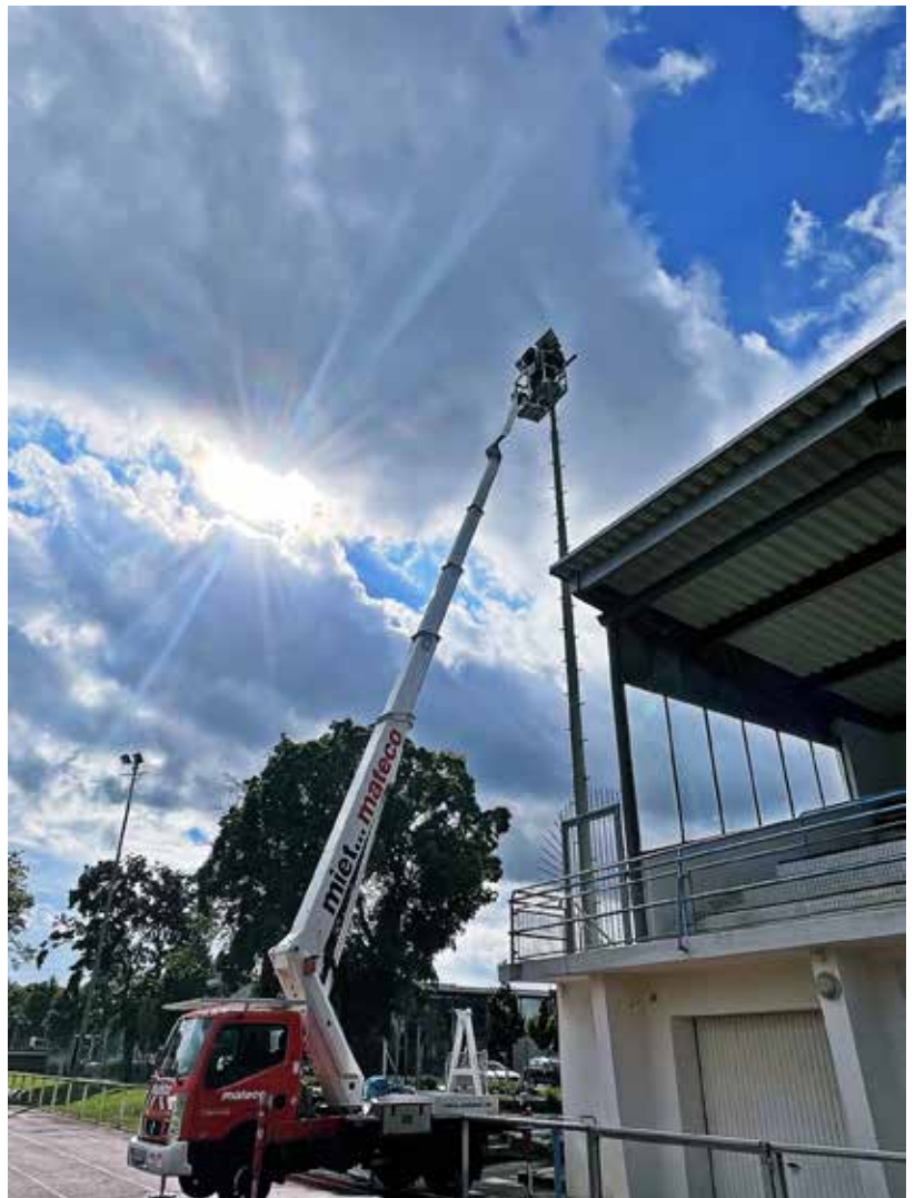
In nur zehn Tagen wurden die 19 Flutlichtmasten auf LED umgerüstet. Alle Fotos: TVA
