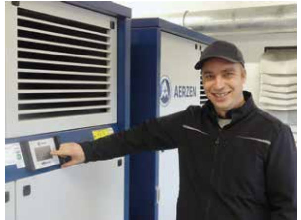
Andreas Schallmoser ist der Leiter der Altöttinger Kläranlage. Foto: Uli Kaiser
