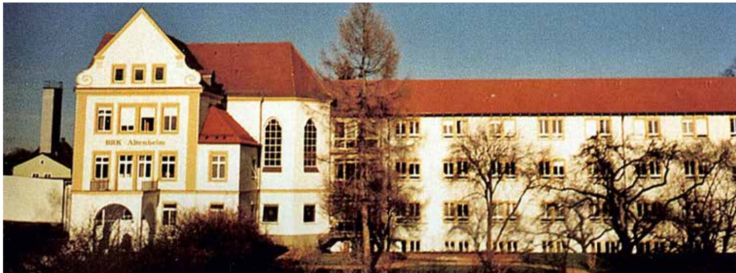
Das Eingangsportal und die Kapelle des alten Krankenhauses mit dem sanierten Ostflügel. Der Westflügel war 1987 bereits abgebrochen worden.
