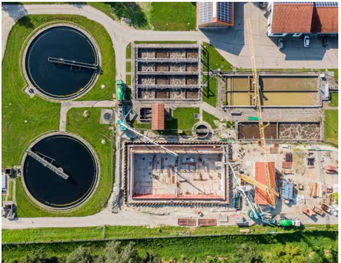
Ein Blick auf die gesamte Anlage, während des Baus der neuen Biologie. Diese umfangreichen Bauarbeiten beeinträchtigte die täglichen Arbeitsabläufe nicht, weil stets geschickte Lösungen gefunden wurden. Foto: Kläranlage
