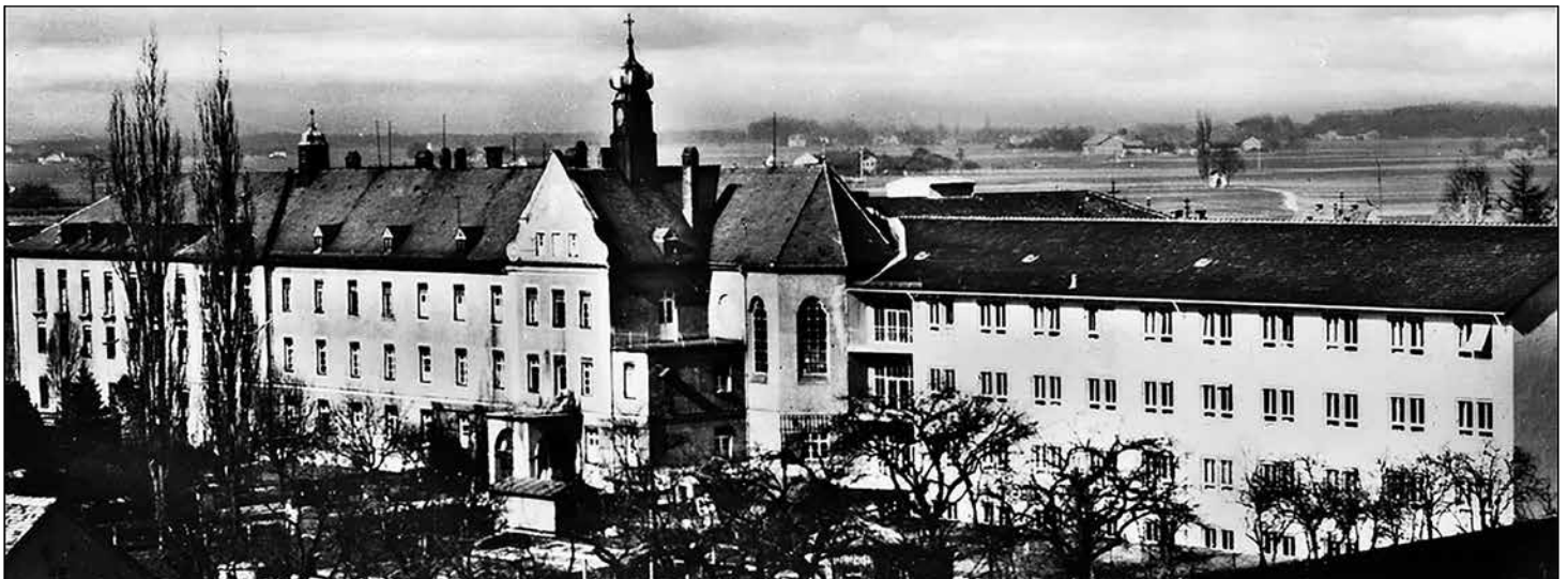
Durch den Anbau im Osten und Norden 1955/56 wurde das Krankenhaus um fast das Doppelte vergrößert. (Postkarte von 1957) Foto: Stadtarchiv
