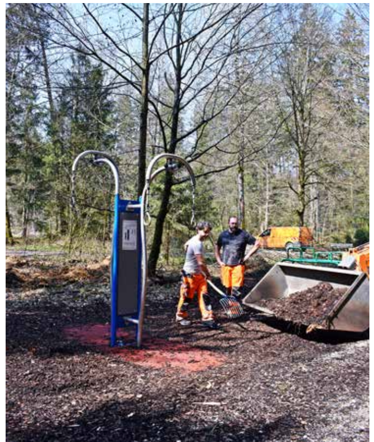
Der Bauhof bringt die Stationen auf Vordermann. Foto: Stadtverwaltung
