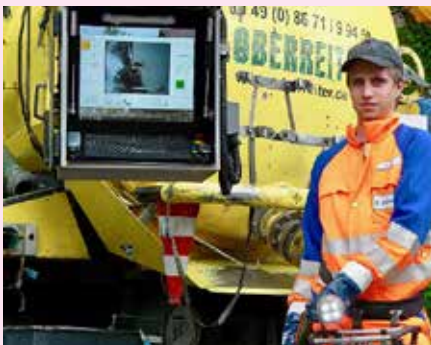
Im Bild ein Lehrling bei der Kanalreinigung. Die Arbeiten werden von der Straße aus per Fernbedienung durchgeführt.
