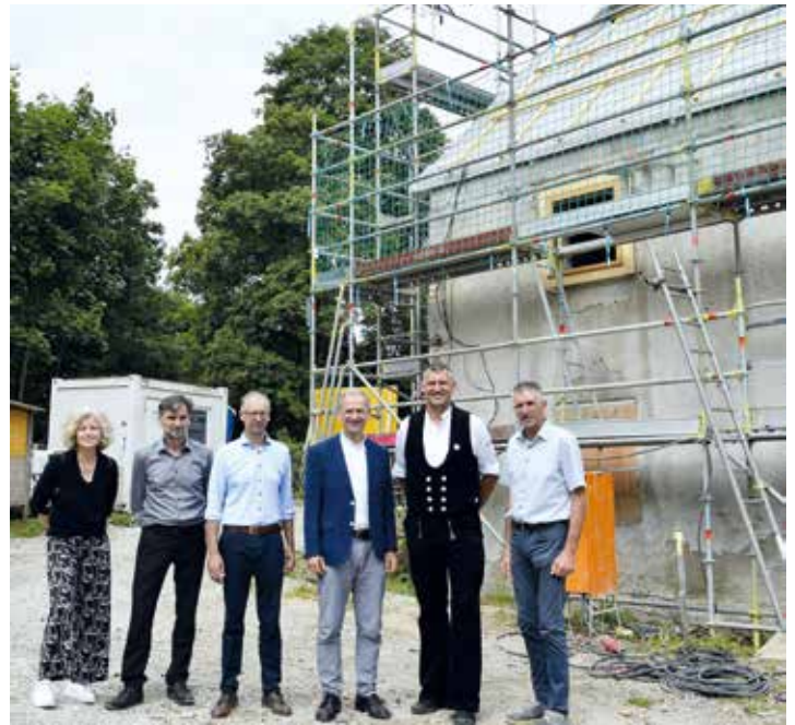
Freuten sich über die Rohbaufertigstellung des gemeinsamen Jugendzentrums (von links): Dipl.-Ing. (FH) Architektin Barbara Karl, Dipl.-Ing. Architekt Herbert Markert, Neuöttings Bürgermeister Veit Hartsperger, Altöttings Bürgermeister Stephan Antwerpen, Zimmermeister Reinhard Obermeier und Winhörings Bürgermeister Karl Brandmüller. Foto: Stadtverwaltung
