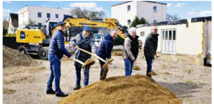
Den Spatenstich für das Haus der Vereine setzten (von links) Christian Holzinger (Vorstand DAV Sektion Neuötting-Altötting), planender Bauingenieur Harald Fuchshuber, Erster Bürgermeister Stephan Antwerpen, Otto Gumpendobler (Geschäftsführer der mit den Baumeisterarbeiten beauftragten Otto Gumpendobler GmbH) und Bauamtsleiter Hubert Rabenbauer. Foto: Stadtverwaltung
